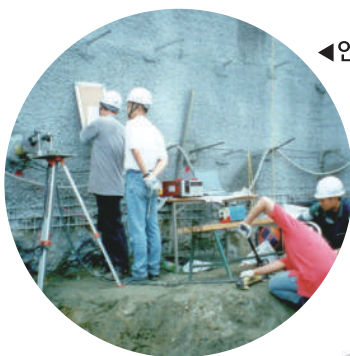
③ 배수공 설치 Shotcrete타설후 지압판, NUT체결
