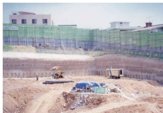
▲ 성산동 재개발 APT (면정리+제거식 S/N+Shotcrete)
