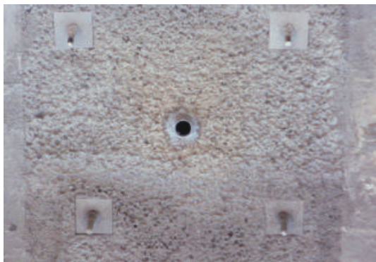
③ 배수공 설치 Shotcrete타설후 지압판, NUT체결
